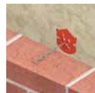
Crochet avec une partie ondulée à ancrer dans le mur intérieur et une partie plate torsadée pour le mur extérieur en maçonnerie collée ou à joints fins.
