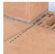
Crochet plié à une extrémité à 90° et l'autre ondulée. Il est posé sur les murs intérieur et extérieur. Disponible en finition galvanisée ou inox A2 (\_ = G ou I2).
