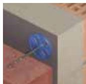
Crochet avec une partie ondulée à ancrer dans le mur intérieur à l'aide d'une cheville PVC et une partie plate ondulée pour le mur extérieur en maçonnerie. Disponible en finition galvanisée ou inox A2 (\_ = G ou I2).
