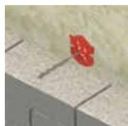
Crochet avec une partie ondulée à ancrer dans le mur intérieur et une partie plate torsadée pour le mur extérieur en maçonnerie collée ou à joints fins. Disponible en finition galvanisée ou inox A2 (\_ = G ou I2).
