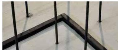
Les joints aux angles ou le long de lignes droites doivent toujours être exécutés comme des joints bout à bout.
