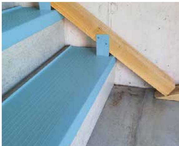
Un système de couverture fiable pour marches en béton de parement. La protection d'escalier robuste protège de manière fiable contre les chocs la marche et l'arête exposée.
