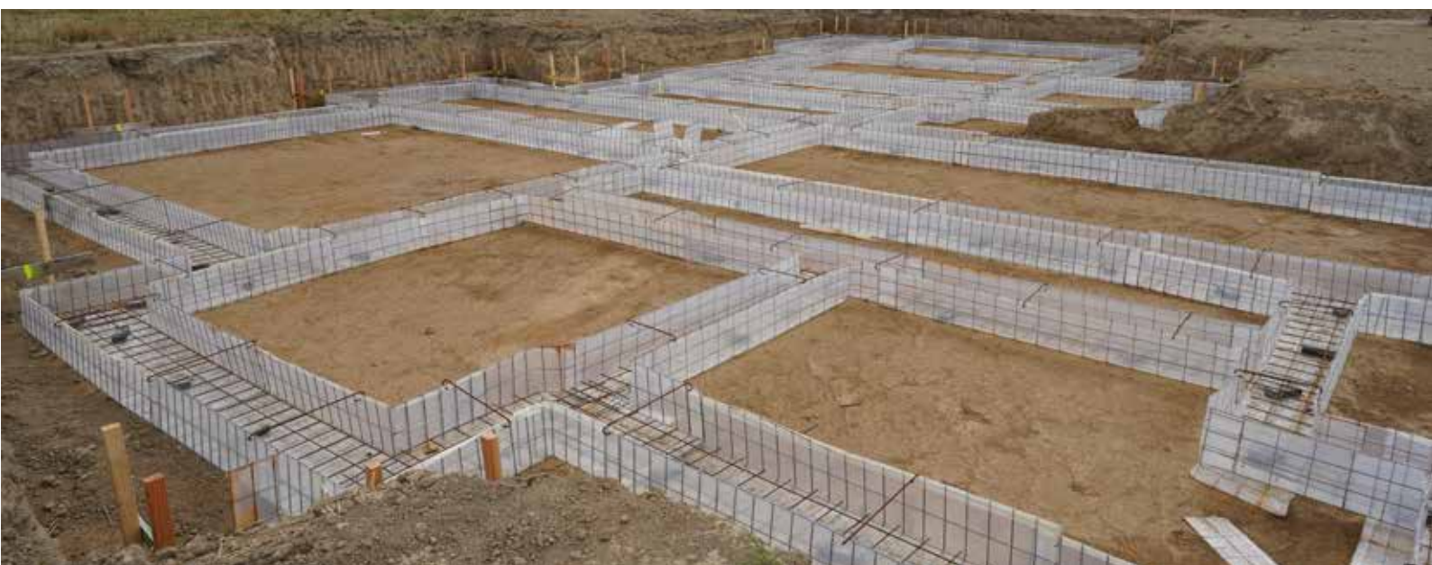
Coffrastic U-geplooide Coffrastic voor funderingsplaten (zie pagina 33).
