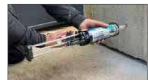
7 Boorgat vanaf de bodem vullen
