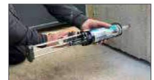
7 Injecter à reculons
